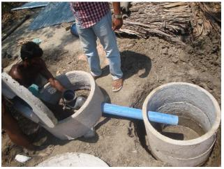
Viele haben dahinter kleine Tanks, die dann von Dalits geleerte werden, aber die Betonringe und die Deckel darüber sind zu oft nicht angedichtet oder brechen
